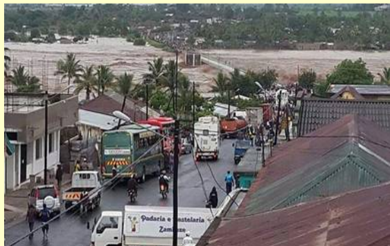
Eine über 100m lange Brücke in Mocuba über den Licungo auf der einzigen Nord-Süd-Verbindungsstrasse wurde weggerissen.
